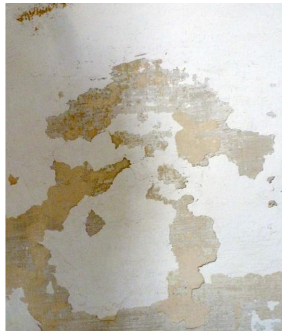
ablösende Farbschichten
